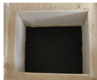
Isolation et étanchéité de la trémie au droit du plancher de l'étage (coté étage)
