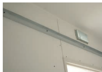
Positionnement et fixation des rails horizontaux à la hauteur requise
