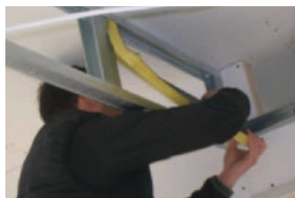
Pose isolant laine de verre semi-rigide (voile noir côté intérieur impérativement)
