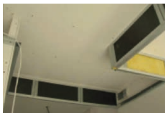
Pose en faux plafond suivant plan d'exécution
