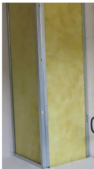
Pose isolant laine de verre semi-rigide (voile noir côté intérieur impérativement)
