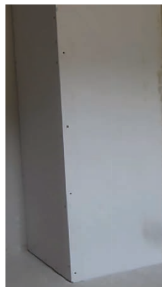
Découpe et fixation plaques de plâtre pour fermeture de la gaine
