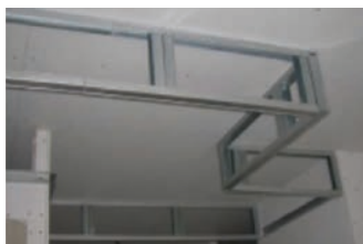
Réalisation et fixation de la structure de la joue
