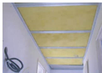
Pose panneaux isolants laine de verre semi-rigide (voile noir côté intérieur impérativement)
