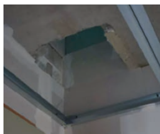
Isolation et étanchéité de la trémie au droit du plancher de l'étage (côté RDC)
