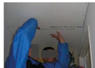
Découpe et fixation plaques de plâtre pour fermeture du plénum
