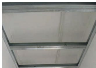
Découpe et mise en place des montants de traverse
